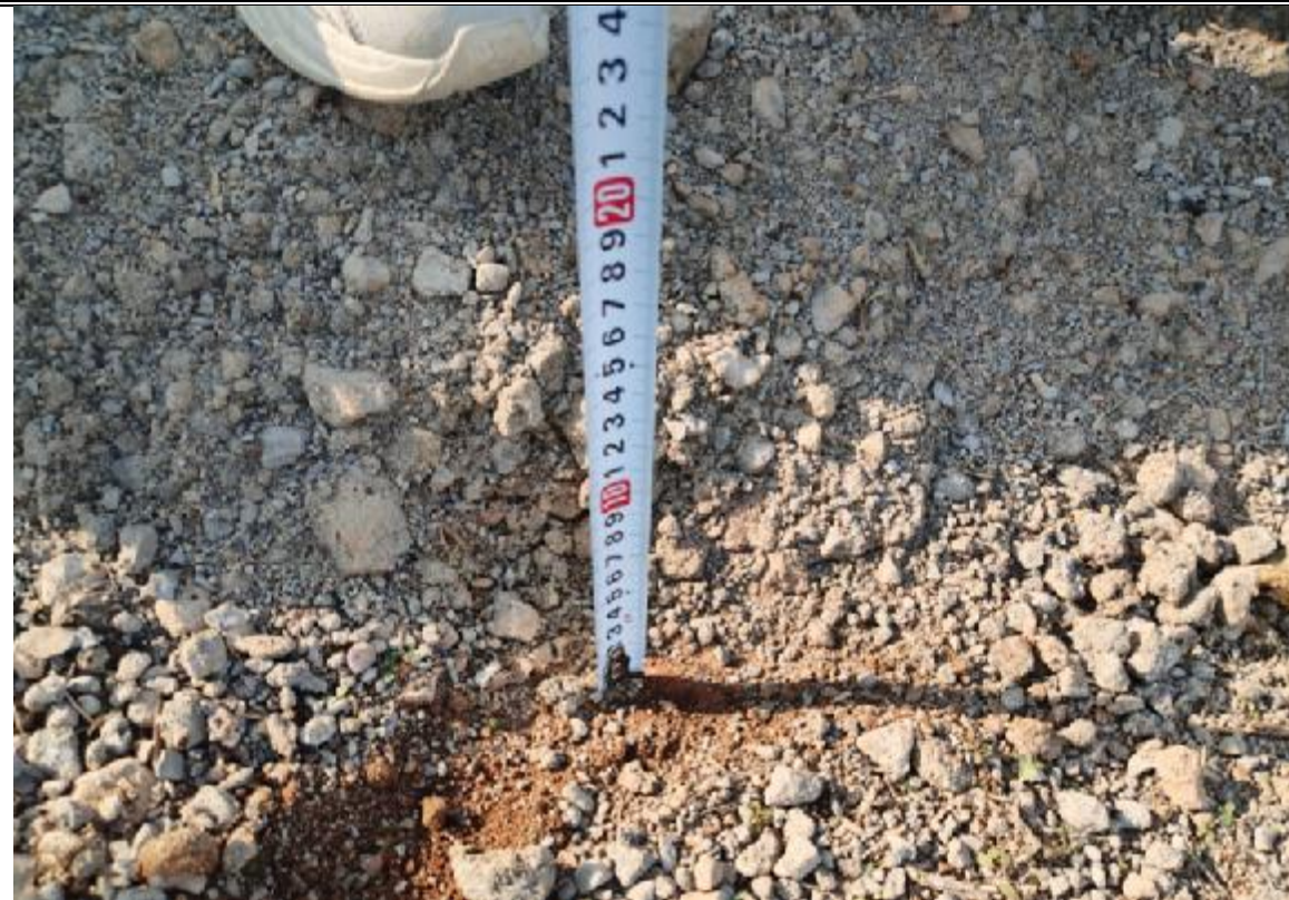
旧路面路面结构图 2
